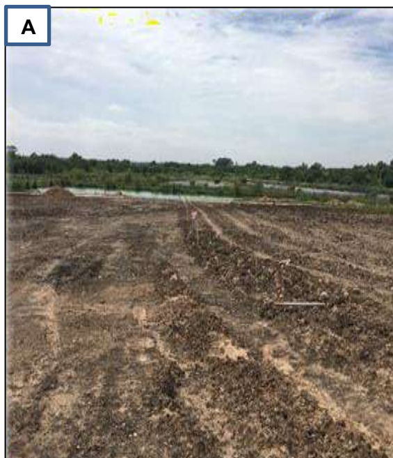
Figura 2. Cierre de relleno sanitario antes (A) y después (B) de la aplicación de barros cloacales tratados y siembra de Cynodon dactylon .
